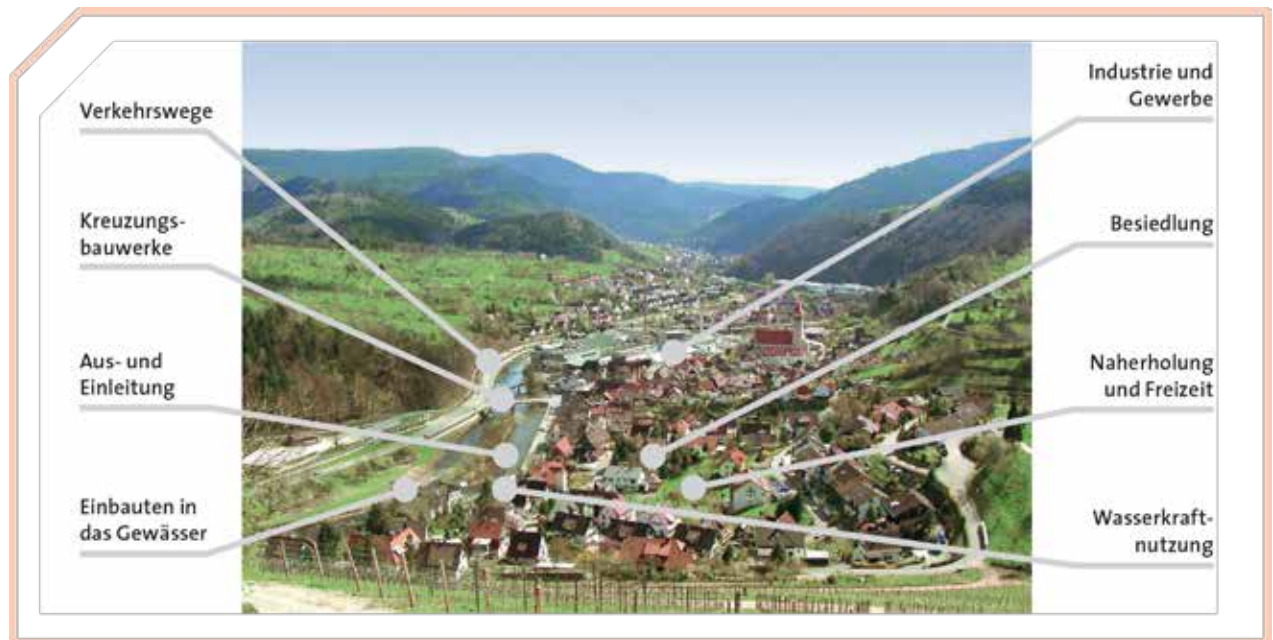
ABBILDUNG 3.5–7 ▶ Technisch ausgebautetes innerstädtisches Gewässer (Murg bei Gernsbach, Baden-Württemberg) mit exemplarischer Kennzeichnung bestehender Nutzungen. (Eigene Darstellung/Boris Lehmann)
