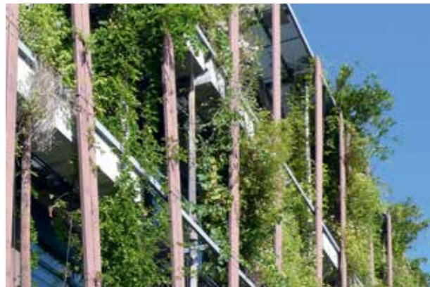
ABBILDUNG 3.2–5 ▶ Vertikale Fassadenbegrünung als außenliegender Sonnenschutz, Institut für Physik, Humboldt-Universität, Berlin-Adlershof. (Foto: Nicole Pfoser, 2009)
