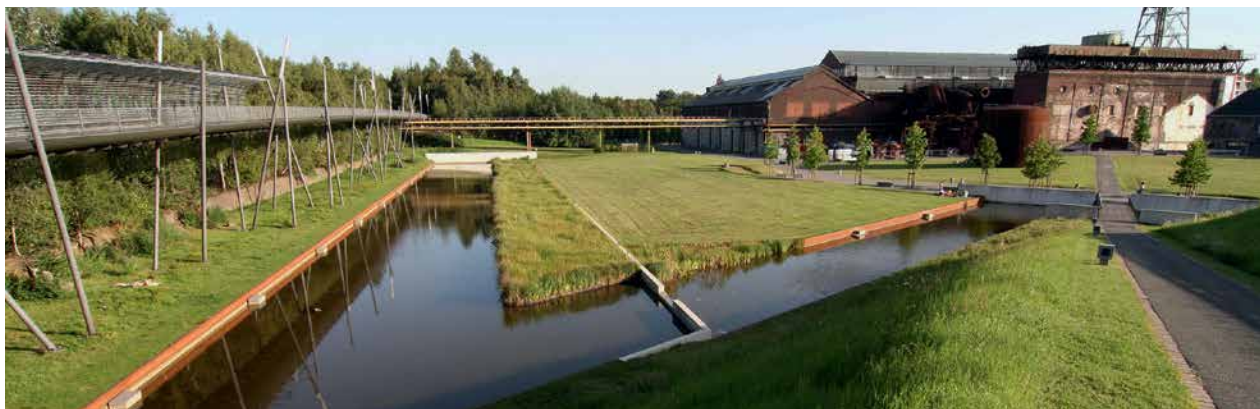
ABBILDUNG 8.2–4 ▶ Ausbau des Kanal- und Wegesystems im Emscher Landschaftspark: Westpark Bochum.
