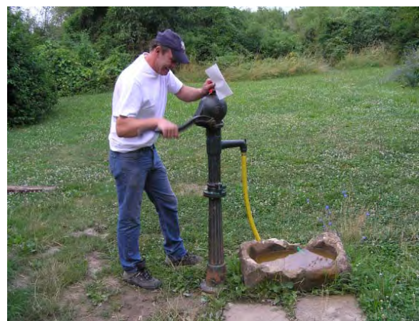
Eine Grundwasserpumpe ist eine Herausforderung für die Wartung
