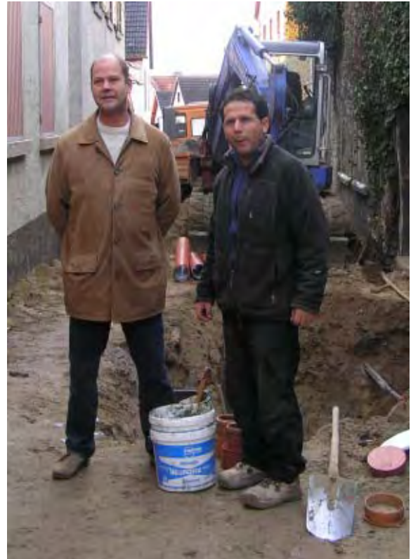
Tiefbaufirma Hebau, hier Herr Conrad mit seinem Bauleiter Morina, liefert immer wieder Erdaushub.
