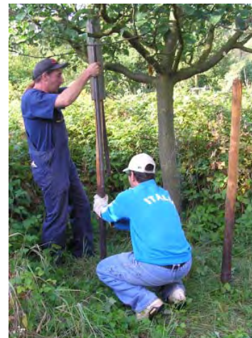
Schlagkatze im Einsatz
