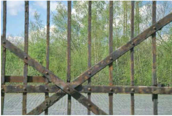
Abb. 4: Manchmal brauchten Flächen nur freigegeben werden.
