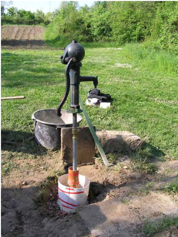
Einbau einer Handschwengelpumpe
