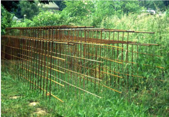
Scharfkantige, nicht gut sichtbare Armierungsteile einer benachbarten Baustelle
